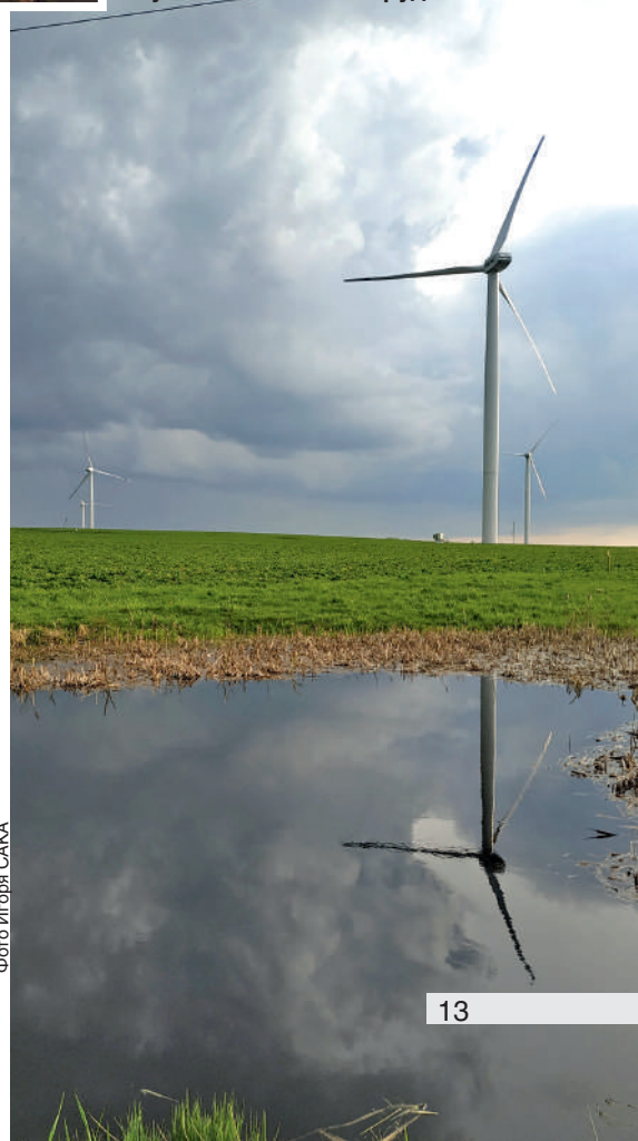
Ветроэнергетические установки в Новогрудке.
